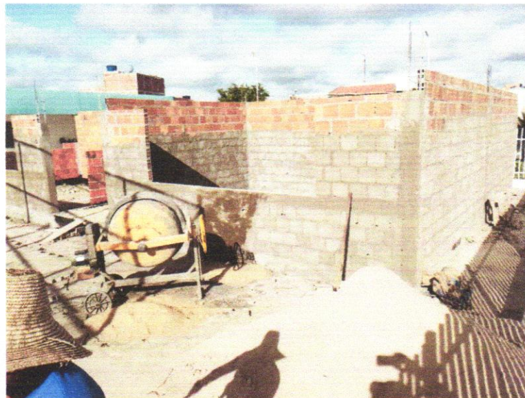
FOTO 04 - CHAPISCO APLICADO EM ALVENARIA (COM PRESENÇA DE VÃOS) E ESTRUTURAS DE CONCRETO DE FACHADA, COM COLHER DE PEDREIRO. ARGAMASSA TRAÇO 1:3 COM PREPARO EM BETONEIRA 400L. AF_10/2022
