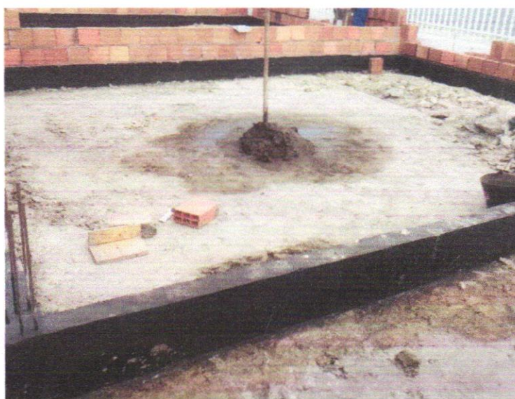
FOTO 08 - CONCRETAGEM DE VIGAS E LAJES, FCK=25 MPA, PARA QUALQUER TIPO DE LAJE COM BALDES EM EDIFICAÇÃO TÉRREA - LANÇAMENTO, ADENSAMENTO E ACABAMENTO. AF_02/2022
