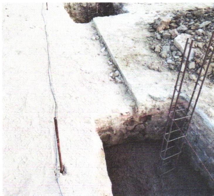
FOTO 07 - ARMAÇÃO DE SAPATA ISOLADA, VIGA BALDRAME E SAPATA CORRIDA UTILIZANDO AÇO CA-50 DE 10 MM - MONTAGEM. AF_01/2024
