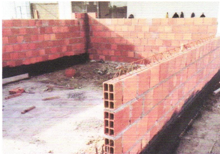
FOTO 03 - Alvenaria bloco cerâmico vedação, 9x19x24cm, e=9cm, com argamassa t5 - 1:2:8 (cimento/cal/areia), junta=1cm - Rev.09
