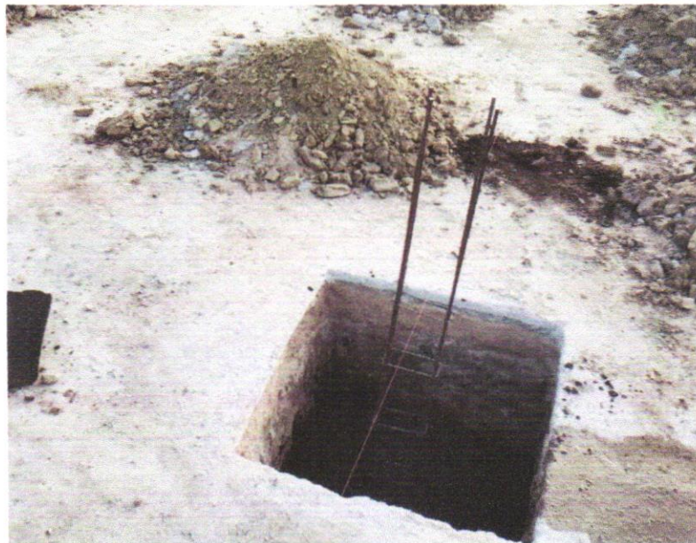
FOTO 09 - ESCAVAÇÃO MANUAL PARA BLOCO DE COROAMENTO OU SAPATA (INCLUINDO ESCAVAÇÃO PARA COLOCAÇÃO DE FÔRMAS). AF_01/2024
